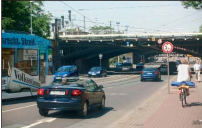
Die Eisenbahnbrücken in Richtung Damaschkeplatz sind heute ein Verkehrsnadelöhr, das beseitigt werden muss. Die Umgestaltung Magdeburgs geht zügig weiter, davon zeugen zahlreiche Baustellen. Fotos: Tobias Krull
