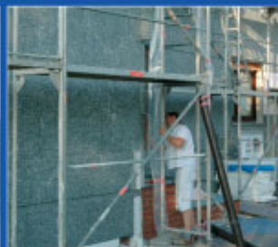
während der Dämmungsarbeiten
