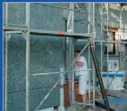
während der Dämmungsarbeiten
