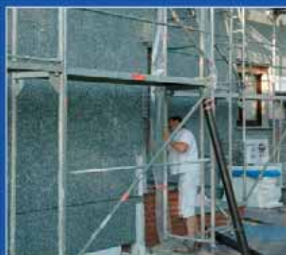
während der Dämmungsarbeiten
