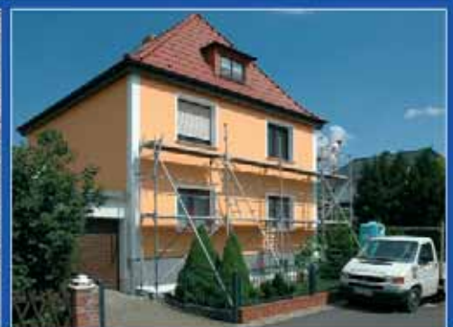
kurz vor der Fertigstellung
