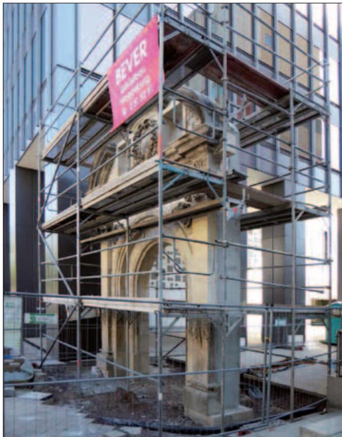
am Breiten Weg eine Betonstützmauer errichtet. An dieser Mauer wurden dann Ende Juli 2016 die aufgearbeiteten und restaurierten Einzelteile des 1966 geretteten Eingangsportals wieder zusammengesetzt. Nach nur zwei Jahren wird
